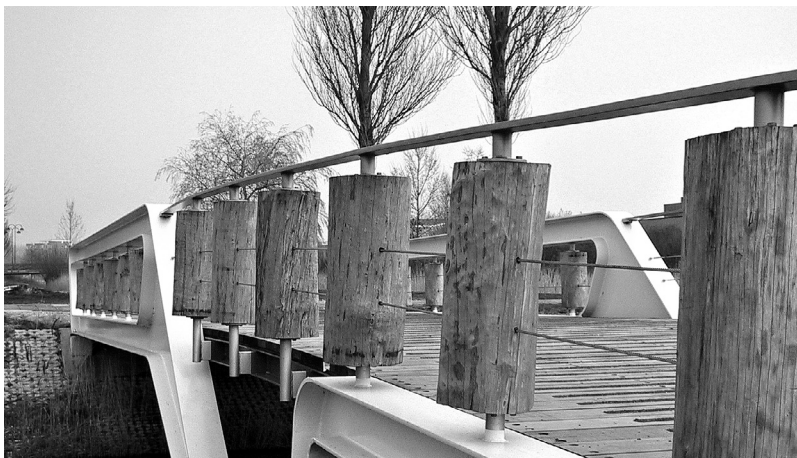
Brücke in Nieuw Venneep. Boden: FSC Cumaru mit Antirutschstreifen, Geländer: FSC Abiurana und Castanharana
